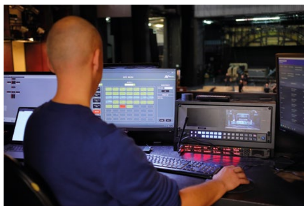
Regie der großen Bühne: KVM-Struktur mittels AV-over-IP-System.
