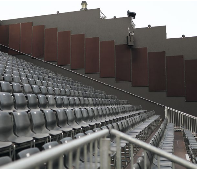
Absorber an den Tribünenseiten, um Reflexionen zu reduzieren
