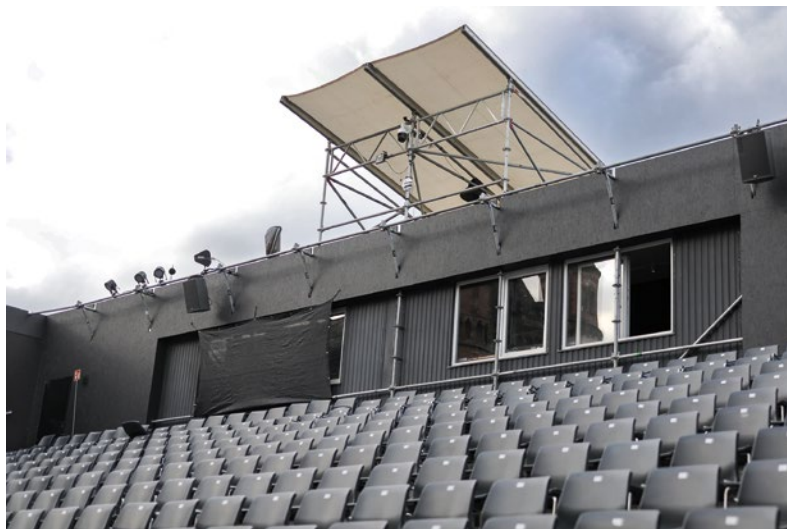
Baucontainer am oberen Ende dem FOH-Bereich der „normalen“ Aufführungen; zwei Rear-Lautsprecher Martin XD12 des Surround-Setups
